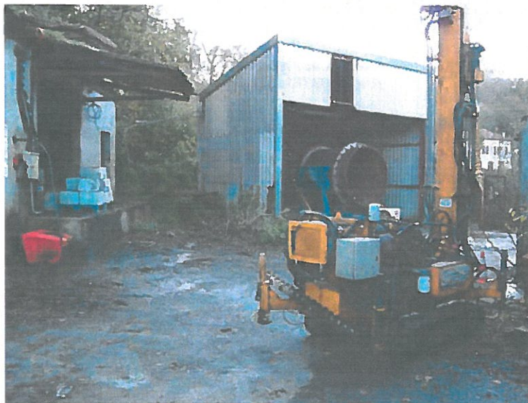
Figure n°21 : Mise en place au PZ3b (à gauche, le poste de distribution de fuel)
